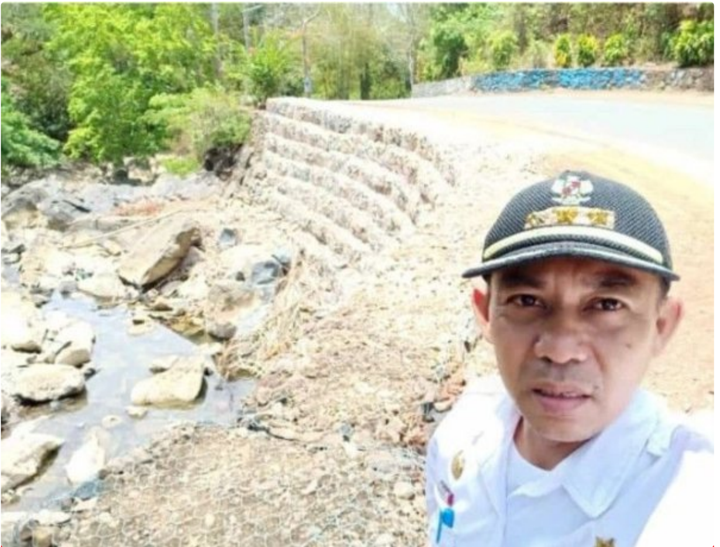
Camat Balocci M. Firmansyah Nur S, STP pantau pelaksanaan pemasangan Bronjong di sungai Sumpang Bita jalan poros Balocci
